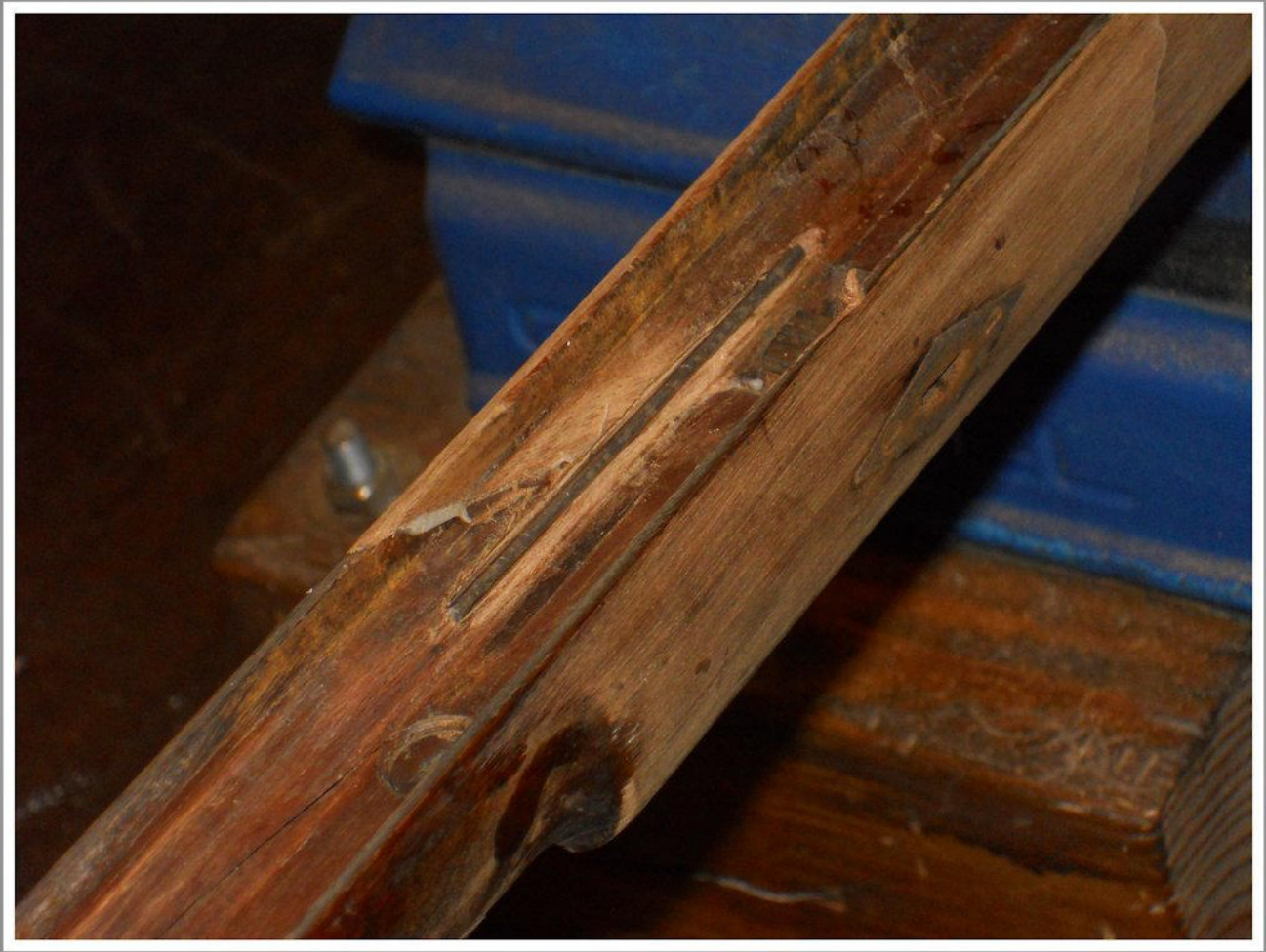
Stahldraht in Armierungsnut einpassen
